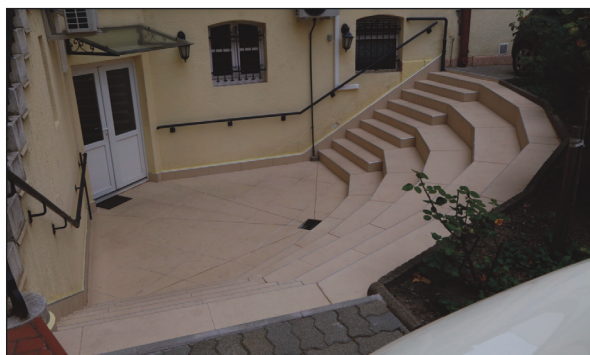
A felújított lejáró
