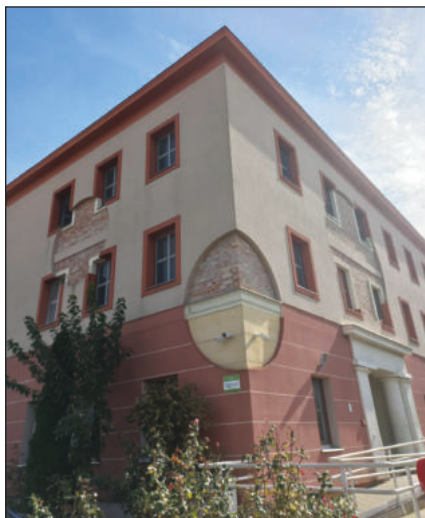
Hajléktalan Ellátó Centrum Dunaújváros
